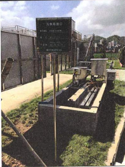
回龙镇污水处理厂废水排放口及标识标牌
