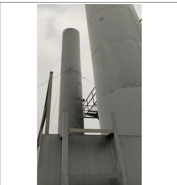
图2 1#排气筒采样平台及监测孔
