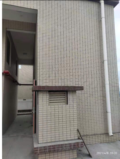
图片4 住宅楼楼顶油烟排放口
