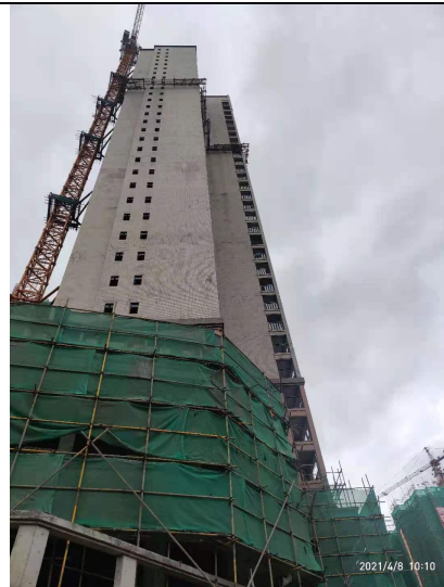
图片 6 项目现状 2
