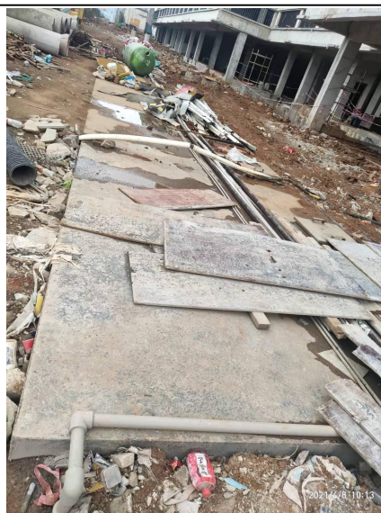
图片8 污水处理站
