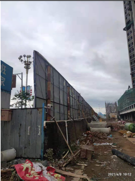
图片 3 施工临时围挡
