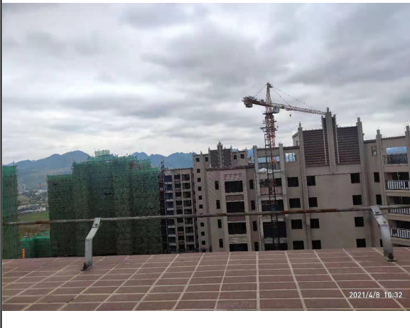
图片 3 项目南侧
