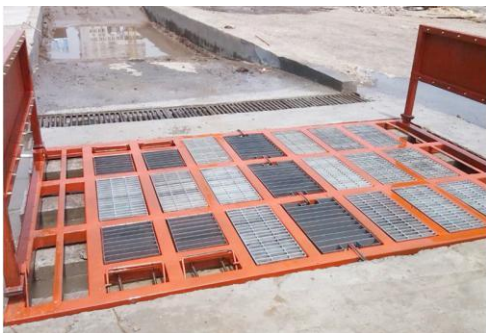
图片 5 洗车废水沉淀
