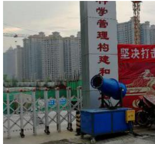
图片 4 抑制扬尘喷雾炮
