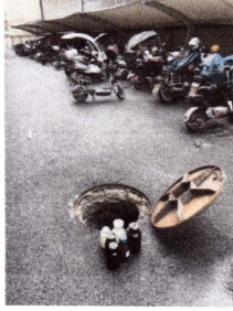
污水处理设施处理前
